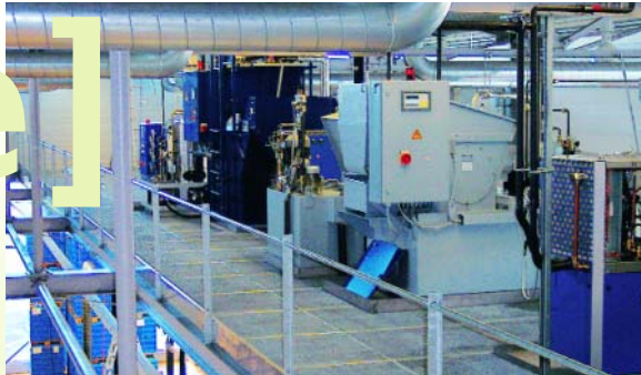
Zwei der insgesamt vier in die Lösung integrierten Maschinen
