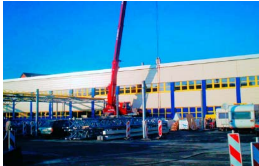
Passgenau: Installation eines wetterfesten Dachlüftungsgeräts ...
