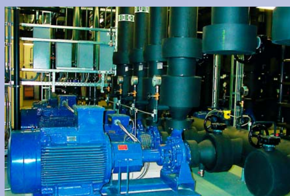
Die Versorgungspumpen der Kältezentrale im EWZ
