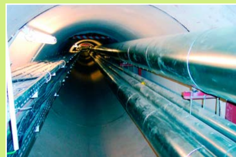
Tunnelblick: ein Teil des 120 Meter langen Montageschachts
