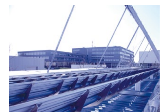
Solarspiegel auf dem Dach montiert Foto: Dürr Systems GmbH
