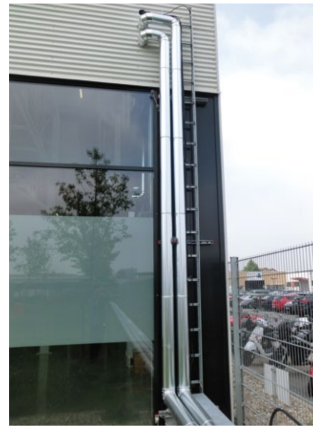
Rohrleitungen mit Dehnungsbogen, durch die bis zu 180 °C heißes Wasser strömen
