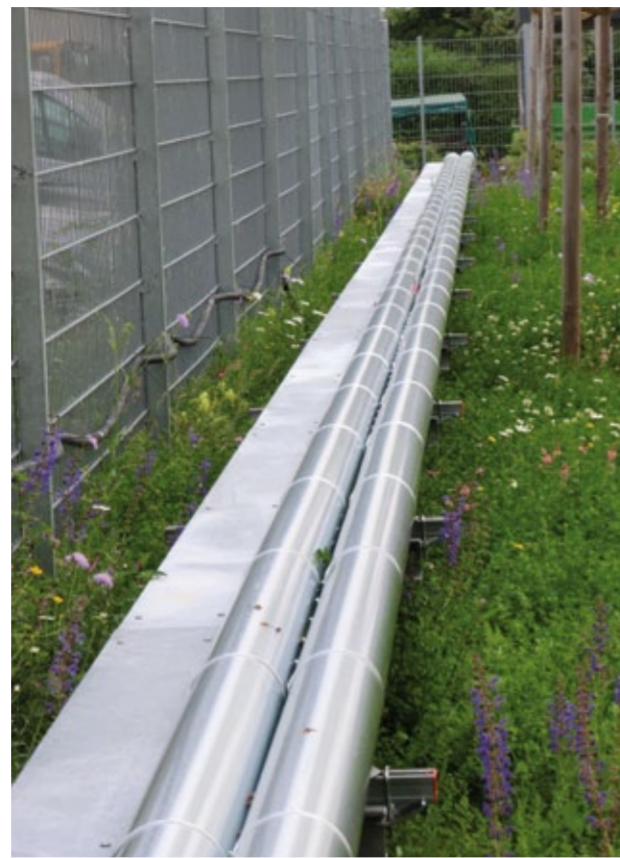
Rohrleitungen mit Dehnungsbogen, durch die bis zu 180 °C heißes Wasser strömen
