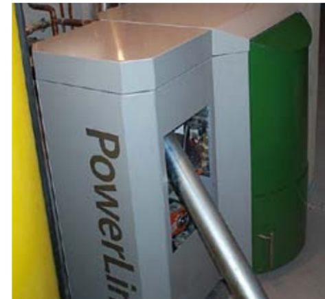
Der neue Pelletkessel mit 20 kW Leistung
