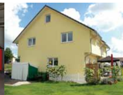
Die ersten Häuser sind fertig
