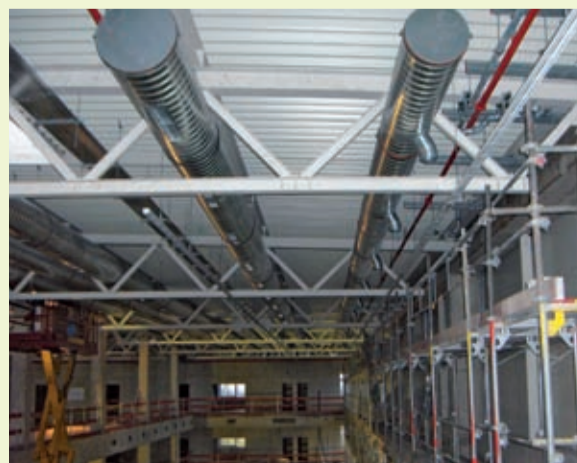
Installation der gesamten Versorgungsleitungen unter dem Hallendach in 18,5 m Höhe ▶
