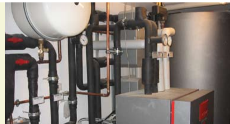
▲ Wärmepumpe mit Pufferspeicher und Heizungsverteilung bestens installiert.
