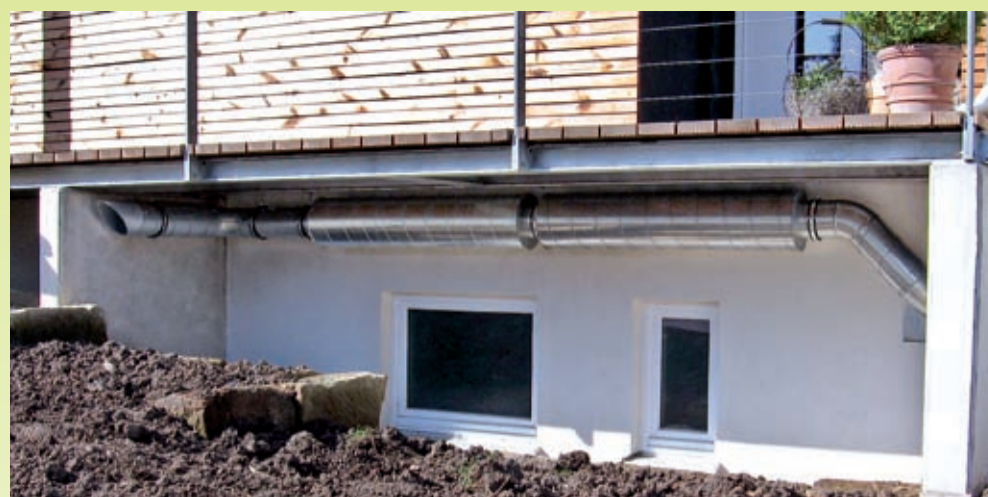
Platzsparend und beinahe unsichtbar: Der Wärmetauscher versteckt sich unter der Terrasse
