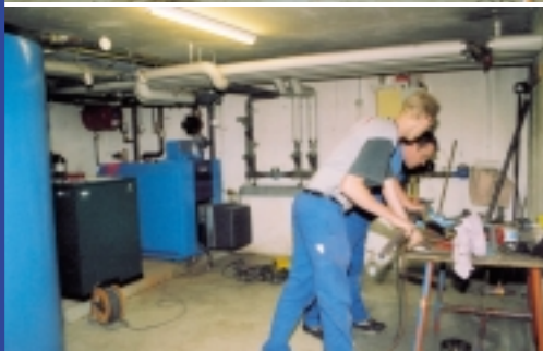
Der alte Ölkessel wiegt über eine halbe Tonne. Der Ausbau ist Knochenarbeit (oben). Der Heizraum ist groß genug, um das Blockheizkraftwerk und den neuen Ölkessel aufzunehmen (unten).
