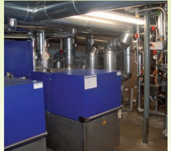
Technikzentrale Blockheizkraftwerke
