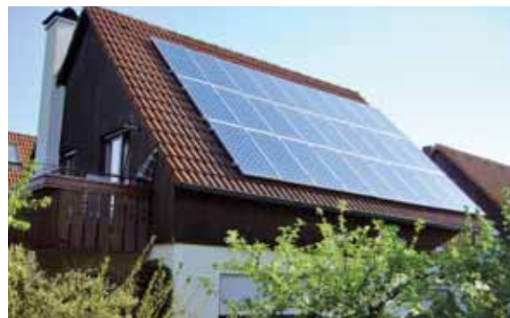
Projekt Häfner: PV-Leistung: 4.598 kWp aus 34,57 qm, Netzeinspeisung: 4.207,4 kWh/Jahr
