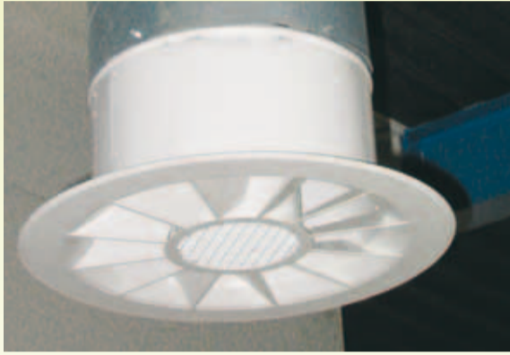
Gleichmäßige Luftverteilung durch Drall-Radialauslässe
