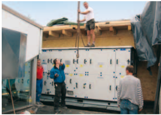
Millimeterarbeit: die Einpassung der RLT-Anlage
