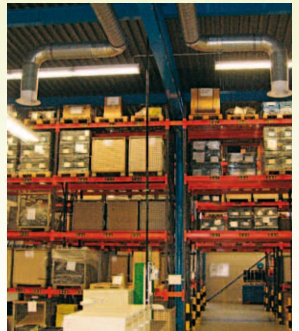
Hohe Einblashöhe vermindert Zuglufterscheinungen.
