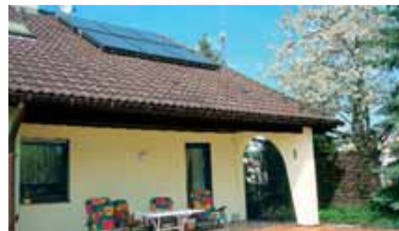
Die Pelletsheizung von Horst Gerwig wird durch Solarkollektoren ergänzt
