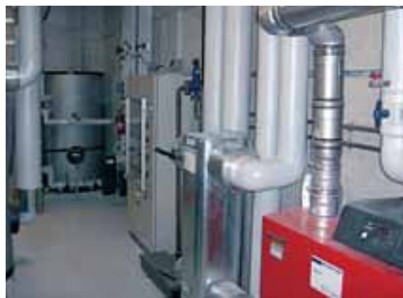
Im Zentrum der Anlage in Wangen stehen zwei Blockheizkraftwerke (links), unterstützt von zwei Gasheizkesseln
