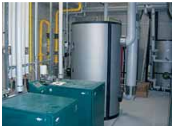
Im Zentrum der Anlage in Wangen stehen zwei Blockheizkraftwerke (links), unterstützt von zwei Gasheizkesseln
