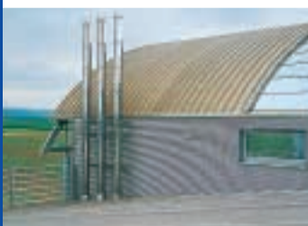
Auf dem Dach direkt über den Prüfständen sind die Kühltürme sowie die Abgas- und Abluft-Schächte installiert.
