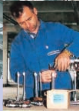
Auf der Baustelle dreht Monteur Uwe Schmidt Rohrschellen für Festpunkte ein.
