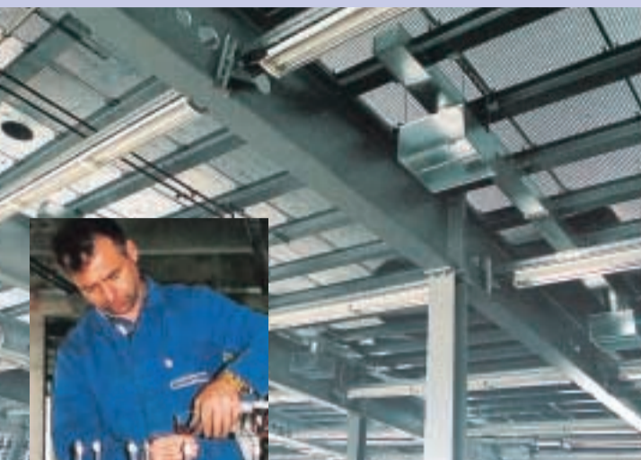
An der Decke der Produktionshalle werden Luftherhitzer und Zuluftanlage mit Induktionauslässen installiert.
