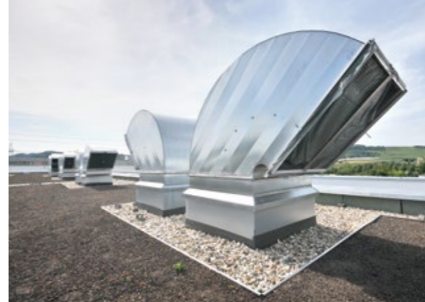
Formschön: Auslässe des Lüftungssystems
