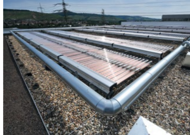
Die Solaranlage kurz vor Inbetriebnahme
