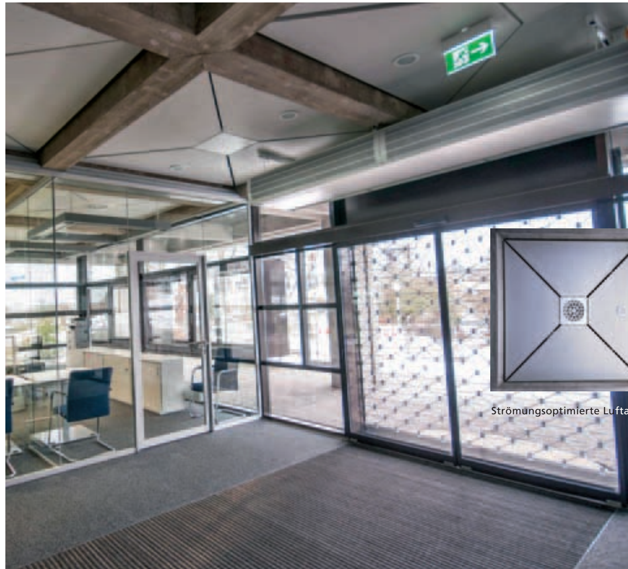
Ein neuer Torluftschleier im Eingangsbereich sorgt dafür, dass die Kälte draußen bleibt
