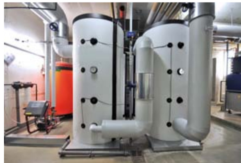
2 Pufferspeicher mit je 1.000 Liter Volumen
