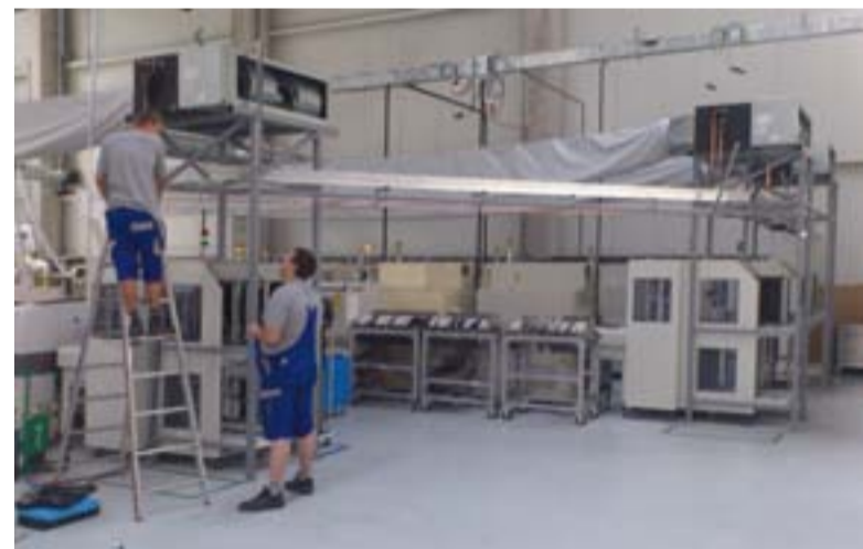
Montage des Schlauchsystems
