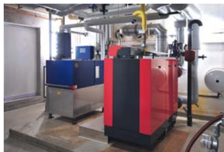
Das Erdgas-BHKW mit Spitzenlastkessel
