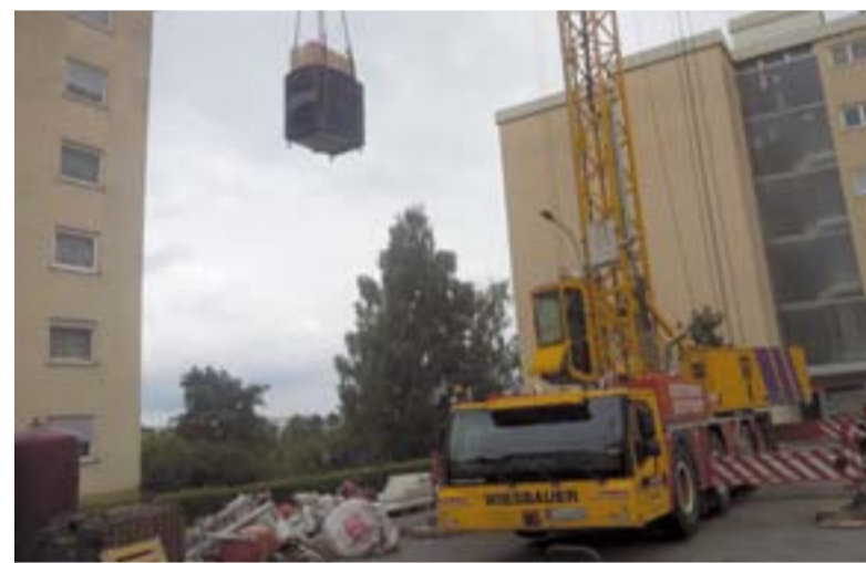
Einbringung des Blockheizkraftwerkes mit Schwerlastkran
