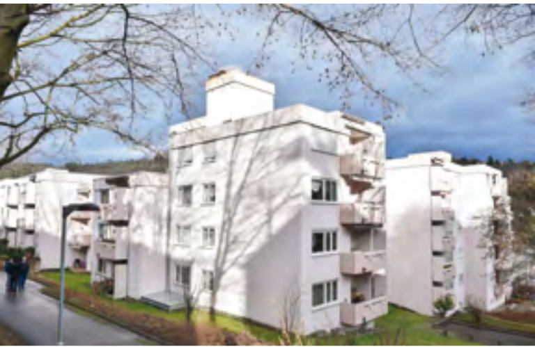
Insgesamt 100 Wohnungen umfasst das Haus-Ensemble
