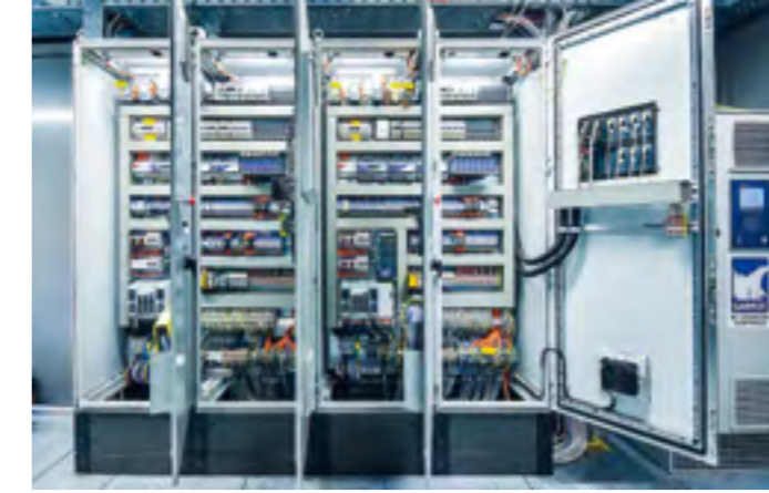
MSR-Technik mit Steuerung der Ammoniakgasüberwachung
