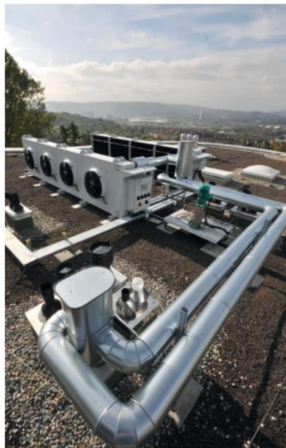
tions-Kältemaschine eingebaut. Diese wird über die Wärme des Blockheizkraftwerkes angetrieben, sodass auch im Sommer eine hohe Laufzeit des Blockheizkraftwerkes realisiert und das Gebäude mit einem hohen Anteil an eigenerzeugtem Strom versorgt wird. Ein weiterer positiver Nebeneffekt ist eine noch kürzere Amortisationszeit der gesamten Anlagentechnik.
