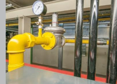
Gasanschluss Heizkessel mit Druckregler
