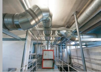
Blockheizkraftwerk mit Zu- und Abluftverrohrung
