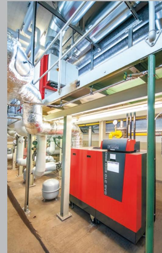
Einer der beiden neuen Gas-Brennwertkessel
