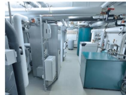
Die Technik-Zentrale mit BHKW und Kältemaschine
