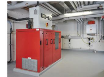
BHKW mit 20 kW elektrischer und 43 kW thermischer Leistung
