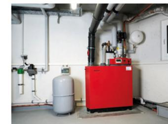
Gasbrennwertkessel mit 39 bis 217 kW
