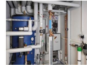
Trinkwasserladesystem mit Frischwasserstation zur legionellenfreien Trinkwasserversorgung
