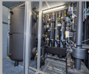
Kältezentrale mit Verteiler und Pufferspeicher
