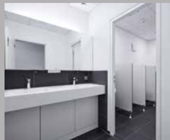
Sanitäre Anlagen mit Mineralgussbecken
