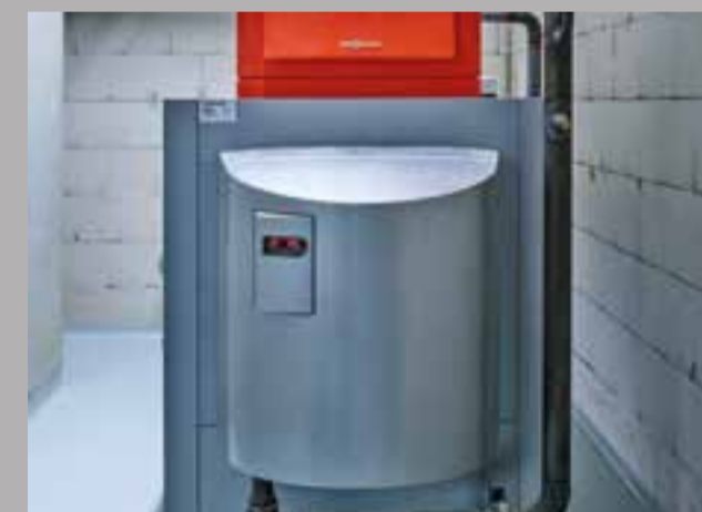
Spitzenlastkessel
