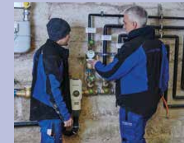
3. Schritt: Die schnelle Reparatur bei Ihnen vor Ort kann direkt erfolgen.
