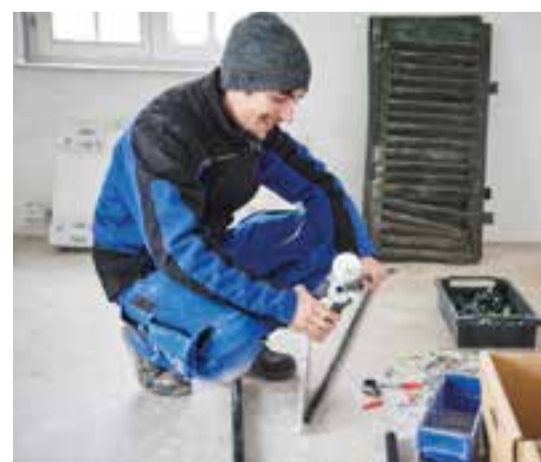
Endmontage der Heizkörper
