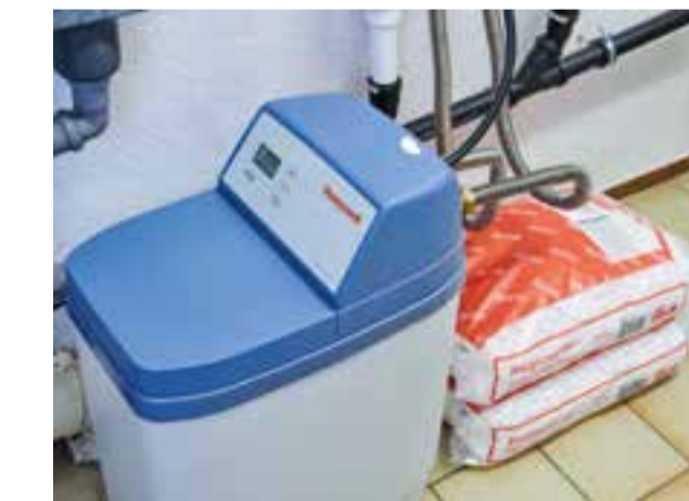
Für beste Wasserqualität: Enthärtungsanlage
