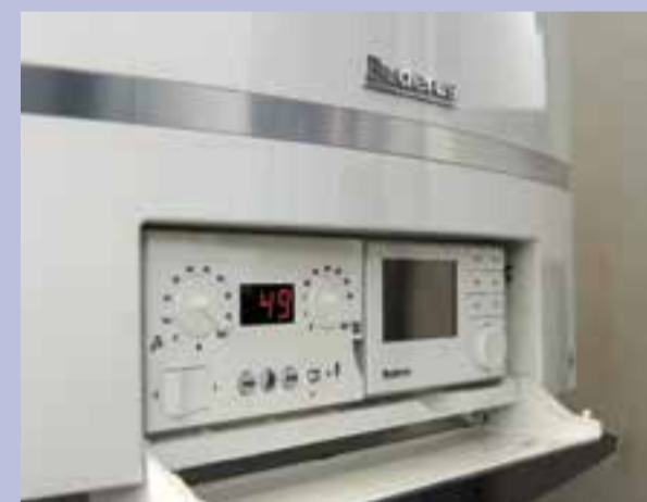
1. Schritt: Fehlermeldung am Geräte-Display ablesen.
