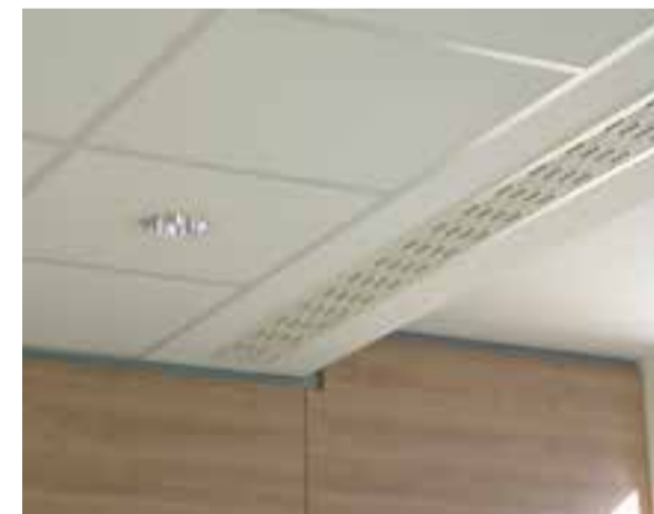
Schlitzauslässe, um kalte oder warme Luft einzubringen
