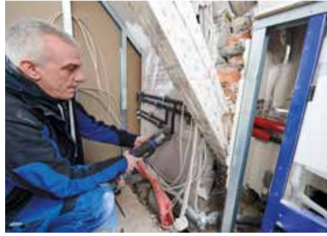
Montage der Wasserleitungen
