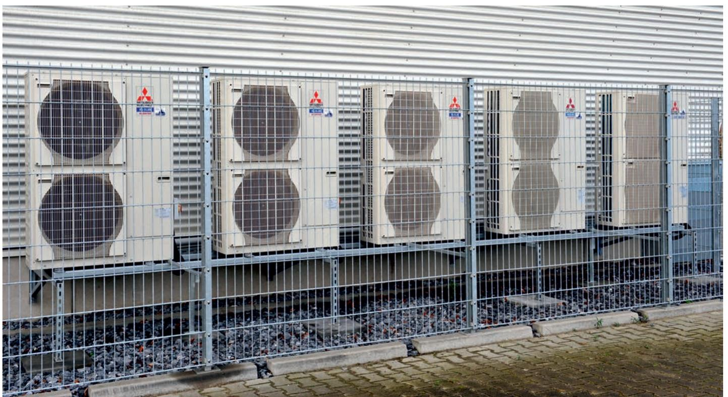
Ebenerdig montierte Außengeräte dieser Multisplit-Klimaanlage kühlen Büroräume leise und leistungsstark
