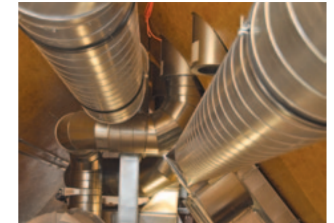
Lüftungskanäle fertigen wir bei Schetter selbst
